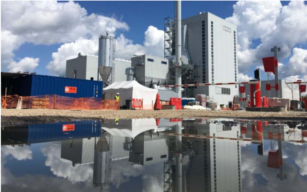
construction de la central de coénergie biomasse de la papeterie de Novillars – photo Akuo Energy
