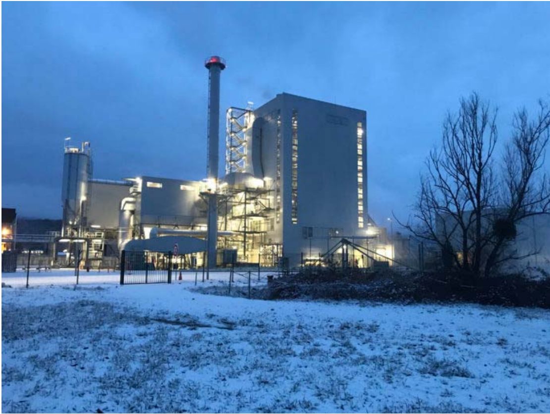
Centrale de cogénération biomasse sur le site de Gemdoubts - photo Akuoenergy
